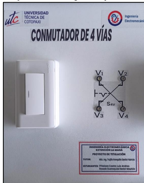
Figura 25: Instalación del conmutador de 4 vías junto a la simbología correspondiente.
