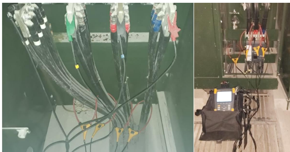
Figura 30. Conexión física del analizador de red en T1
