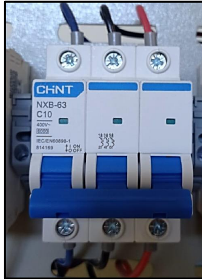
Anexo A.2. Breket C10 de tres polos usado en la protección de los circuitos.
