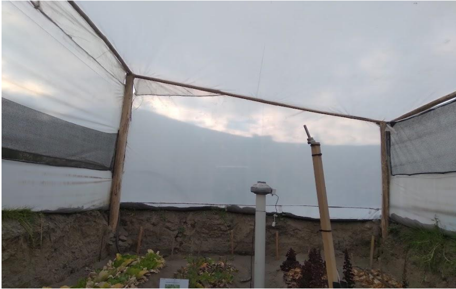
Anexo 13 Sensor 1, Bajo cubierta.
