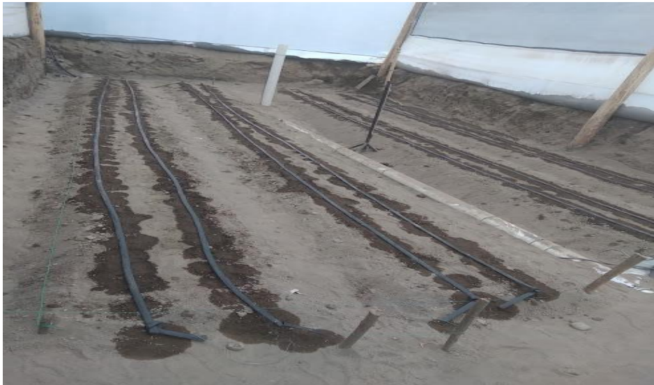
Anexo 10 Sistema de riego por goteo, Bajo cubierta.
