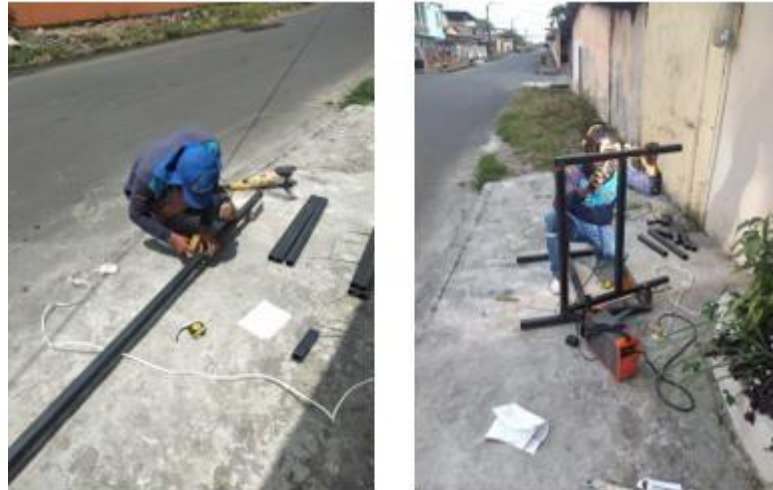
Figura 28 Construcción de la máquina según la NORMA ASTM G65
