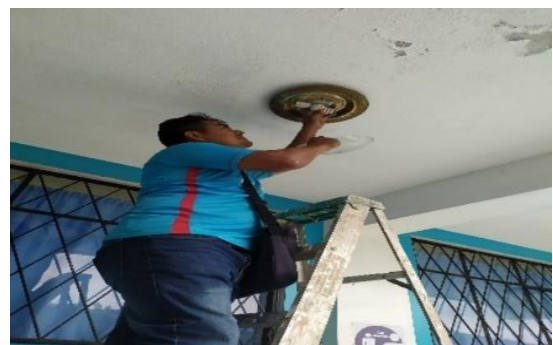
Foto 2. Inspección de los equipos de iluminación del edificio de la UTC.
