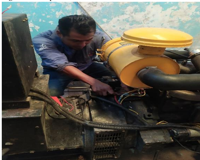
Figura 19. Reparación del encendido auxiliar
