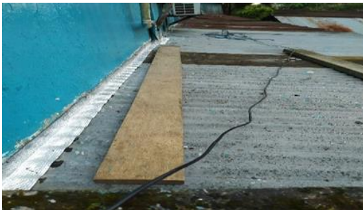
Foto 3. Colocación de Choba como medio de protección de humedad.
