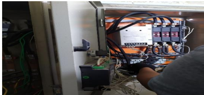
Figura 21. Sustitución de accesorio
