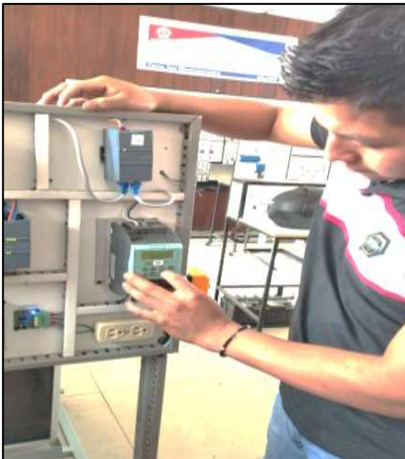
Verificación del variador de frecuencia
