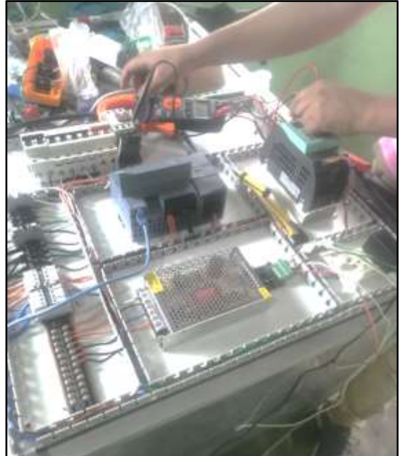
Verificación de continuidad y conexionado de los equipos
