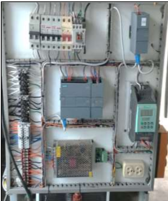
Montaje del tablero en la estructura
