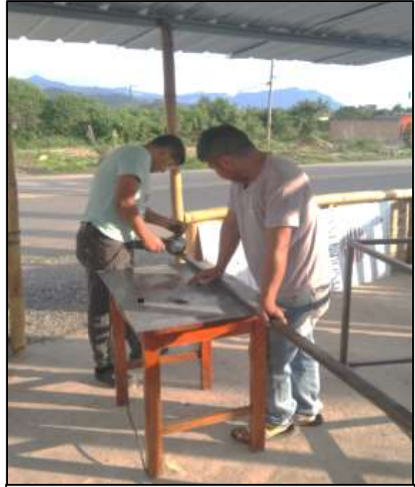
Corte del tubo de la estructura
