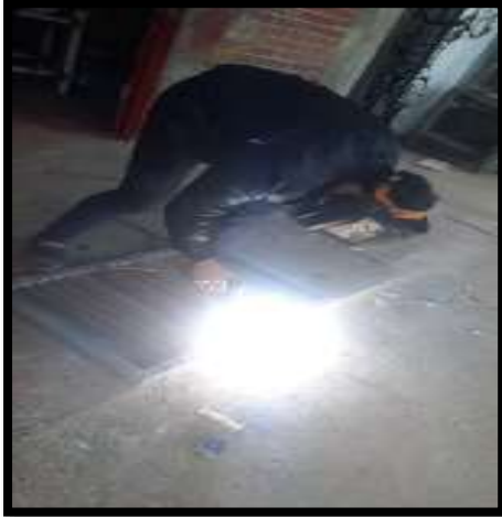
Fotografía 1. Construcción de mesa especial.
