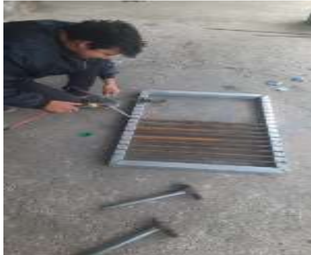
Figura 14. Construcción del marco especial.
