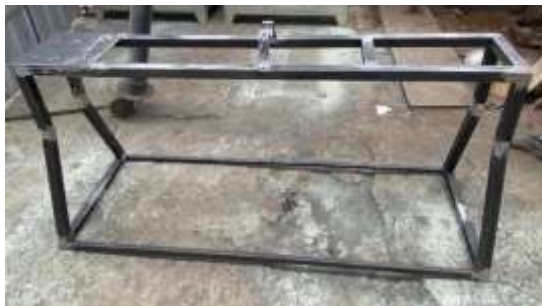
Figura 31 Construcción de la estructura
