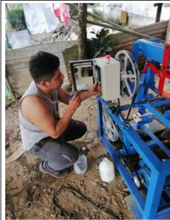
Instalación de tablero de control.
