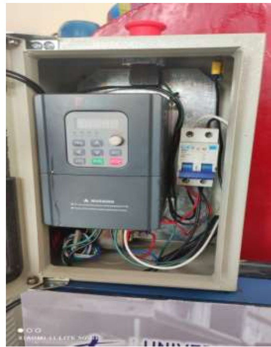
Instalación de variador de frecuencia y protecciones
