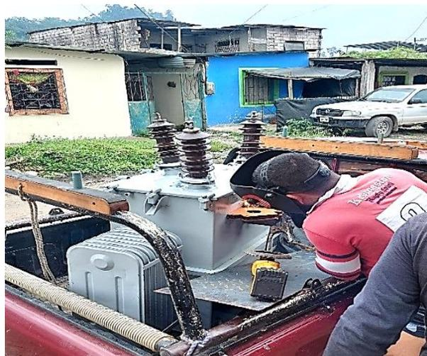
**Figura N°38:** Colocación del transformador trifásico
