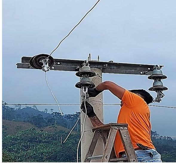
**Figura N°36:** Instalación abrazadera de acero galvanizado
