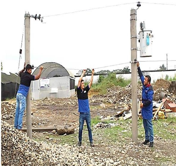
**Figura N°35:** Instalación de aisladores de suspensión, porcelana, 7,5 kv Ansi 52-1
