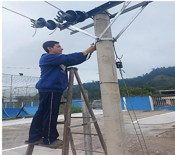
**Figura N°37:** Implementación de dos soportes para el montaje a poste trifásico
