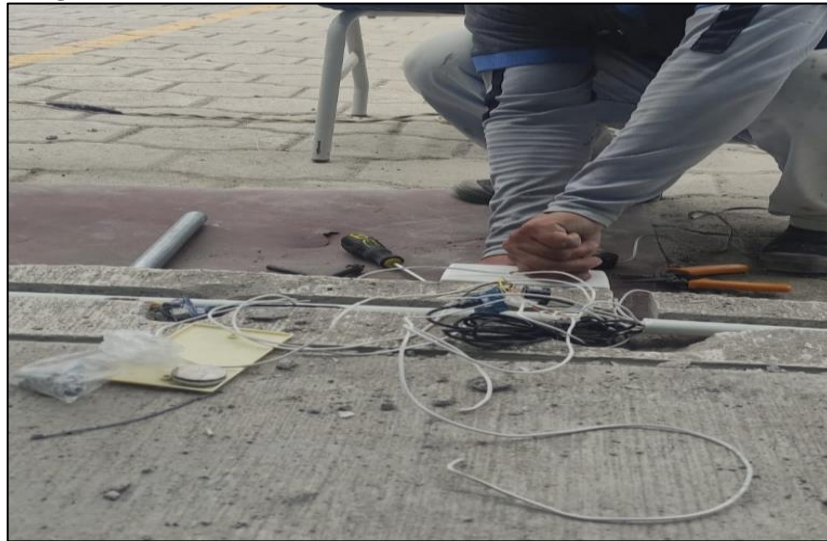
Fotografía 12: Conexiones del sensor al modulo
