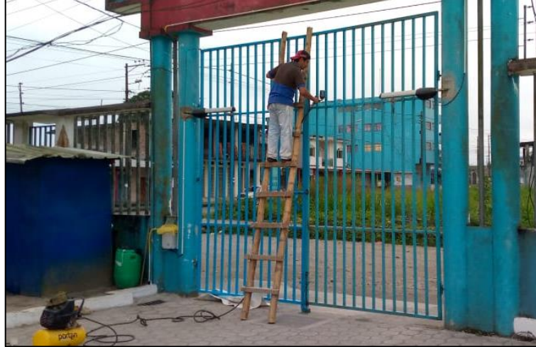
Fotografía 6: relleno y pintado de la puerta
