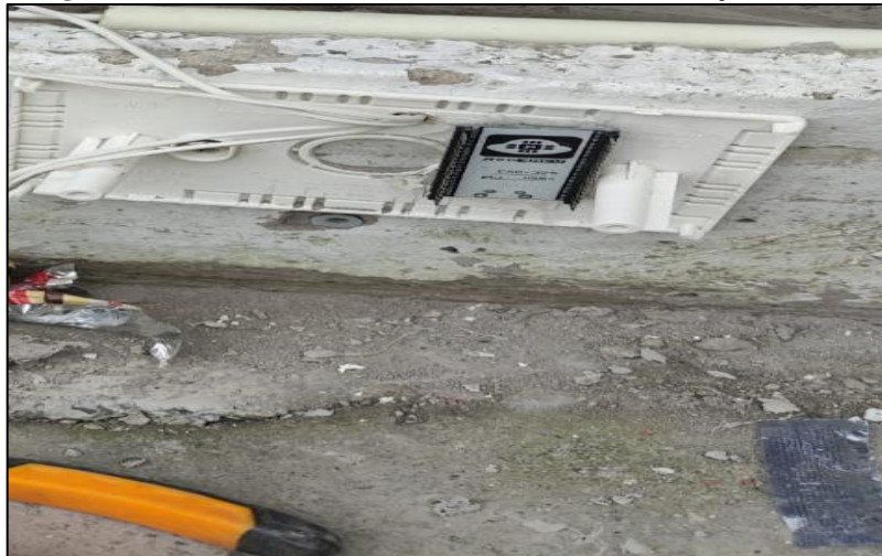
Fotografía 11: Instalación de los módulos ESP32 en cada caja.
