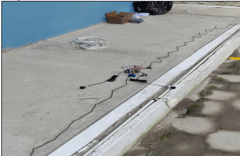
Fotografía 9: Colocación de los sensores AJ-SR04M.
