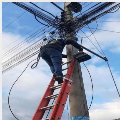
Proceso de instalación en Postes
