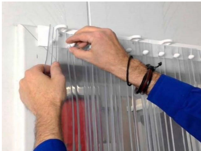
Figura 2.15: Colocación de la cortina en el cuarto frío [18]
