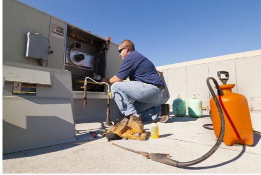
Figura 2.16: Instalación de equipos de refrigeración [18].
