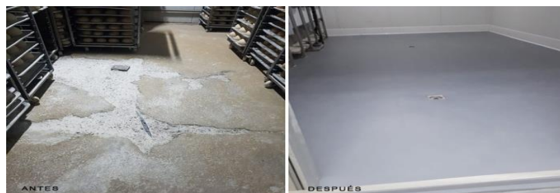
Figura 2.13: Fundición de un piso para la instalación de una cámara frigorífica [18]
