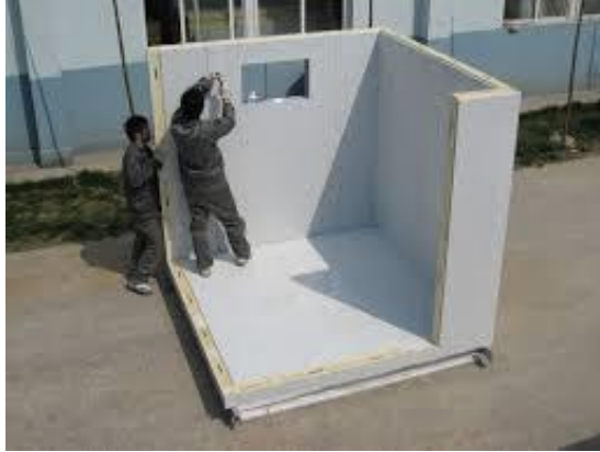
Figura 2.14: Colocación de material aislante [18]
