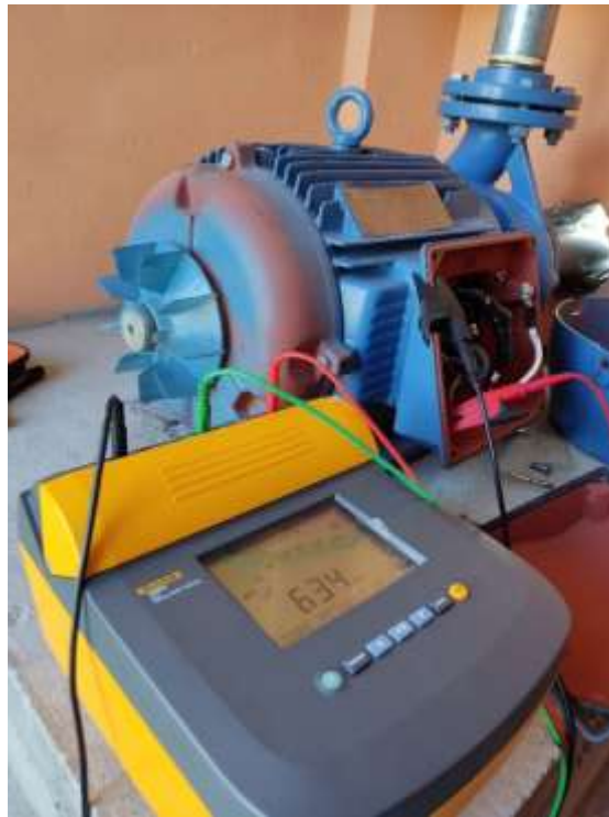
Figura D.3: Prueba de aislamiento mediante el comprobador de aislamiento Fluke 1550C.
