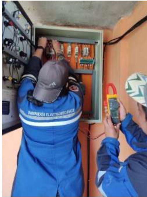
Figura F.1: Verificación de Tensión entre línea y línea.
