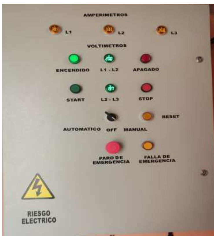
Figura 3.1: Indicadores de Tensión y Corriente
