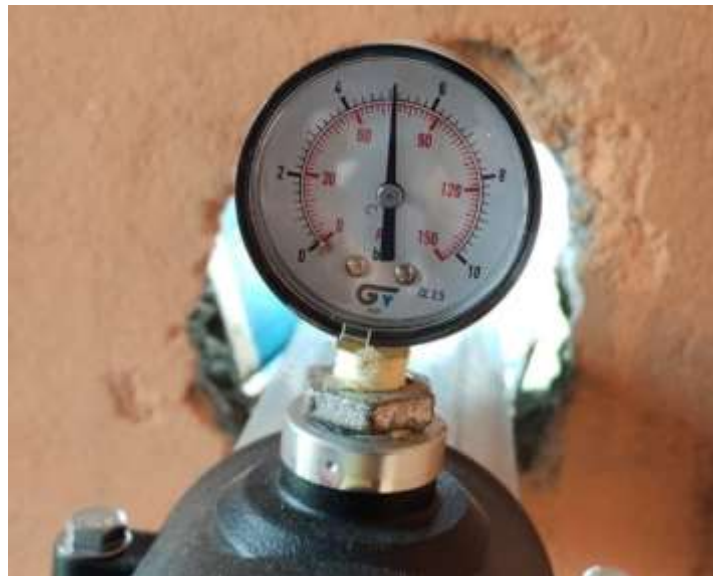
Figura 3.28: Medición de la presión en la descarga.
