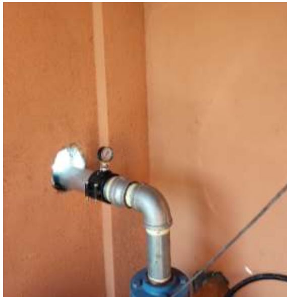
Figura E.4: Instalación del manómetro y accesorios hidráulicos.
