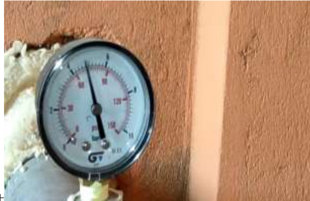
Figura 3.3: Verificación de la presión hidráulica.
