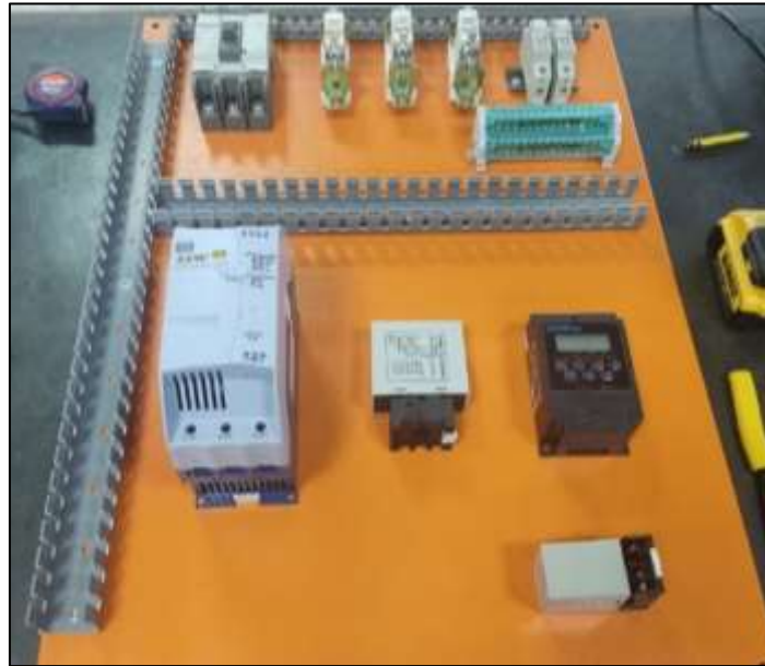
Figura 3.1: Materiales para el sistema eléctrico.
