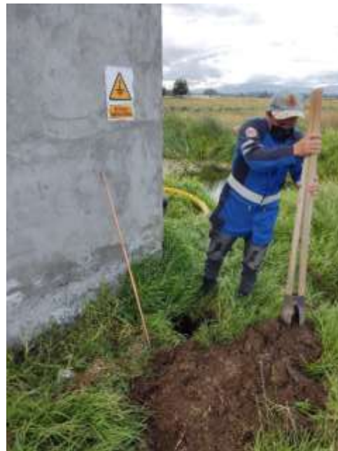
Figura E.6: Instalación del sistema de puesta a tierra.
