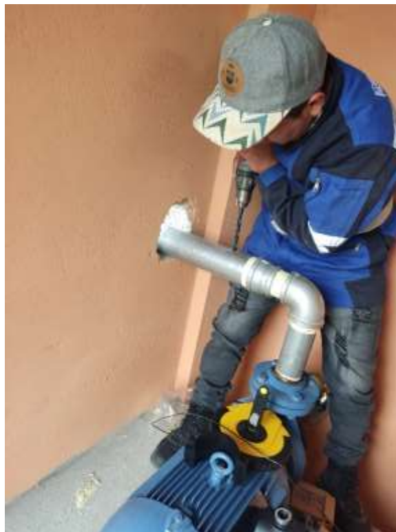
Figura E.2: Instalación de la bomba centrífuga.
