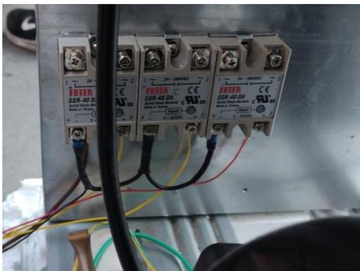
Figura N°- 11 Instalación de los relés solidos
