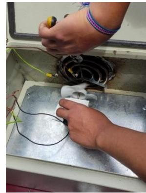
Figura N°- 4 Instalación de Niquelina Eléctrica
