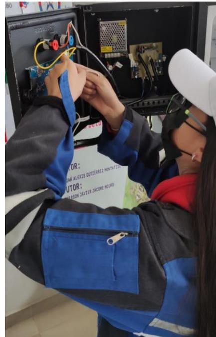
Figura N°- 18 Instalación de luz piloto
