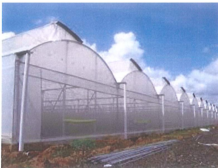
Figura 3.10: Invernadero tipo de raspa y amagado [15].
