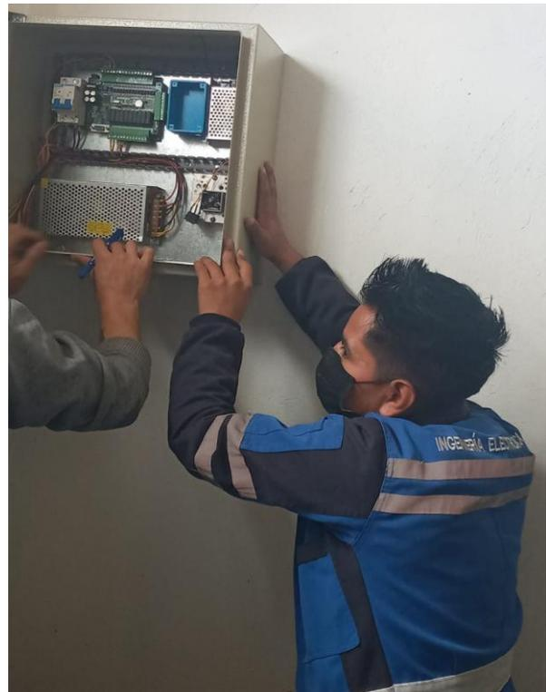
Montaje de dispositivos electrónicos dentro del tablero
