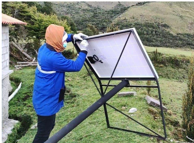
Fig. 5.4. Montaje de los módulos fotovoltaicos
