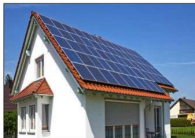
Fig. 3.29. Montaje directo con cubierta inclinada [29]
