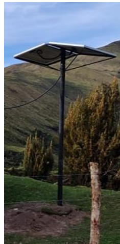
Fig. 5.2. Orientación e inclinación de los módulos fotovoltaicos
