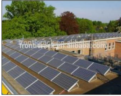
Fig. 3.30. Montaje directo con cubierta plana [29]
