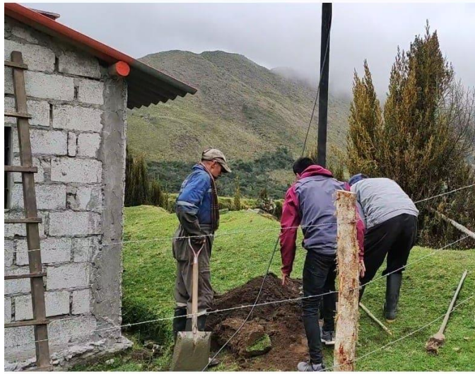
Fig. 5.3. Ubicación de la estructura
