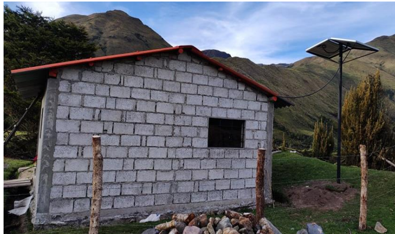
Fig. 5.6. Estructura montada en su posición final
