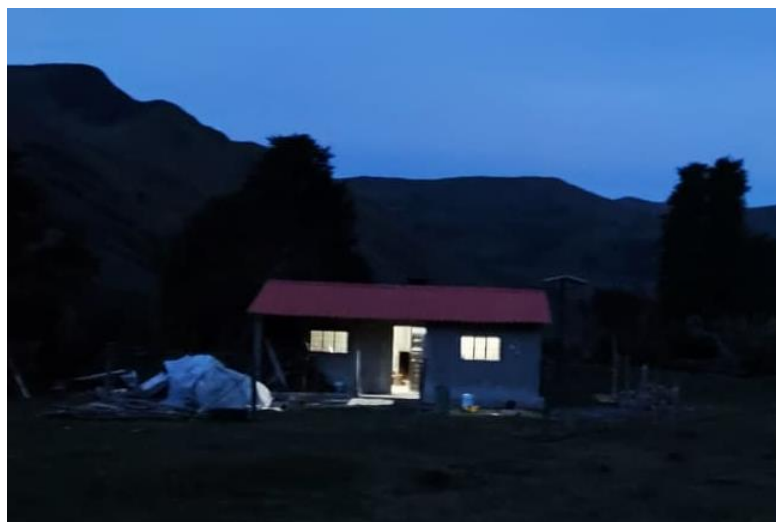
Fig. 5.10. Proyecto culminado en la vivienda beneficiaria
