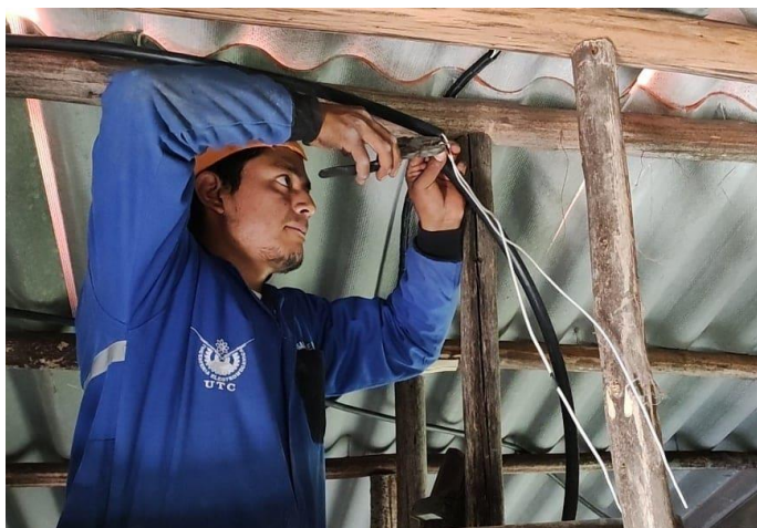
Fig. 5.9. conexión de los circuitos de la vivienda
