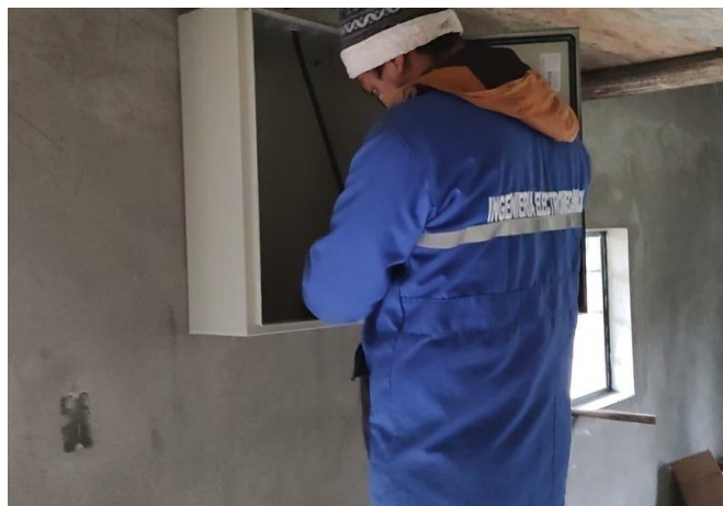
Fig. 5.7. Colocación del gabinete de protección
