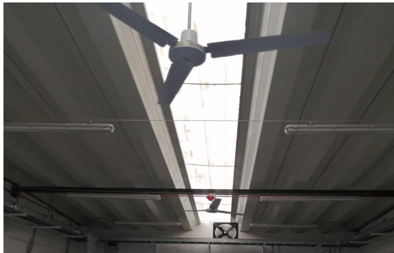
Figura 5. 5. Instalación de tres ventiladores y dos extractores mecánicos.
