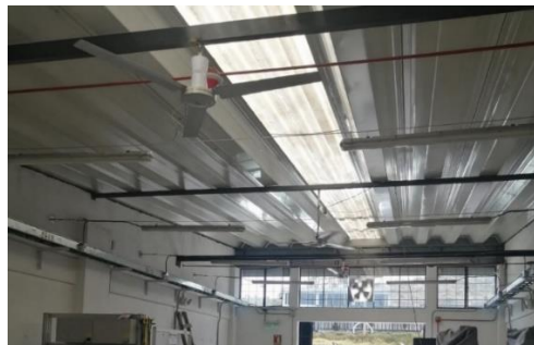
Figura 5. 3. Instalación de tres ventiladores y un extractor mecánico.
