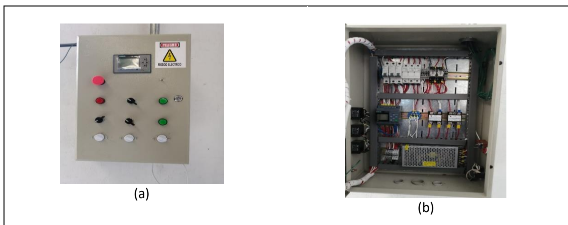
Figura 4. 9. a) Tapa frontal. b) Elementos internos
