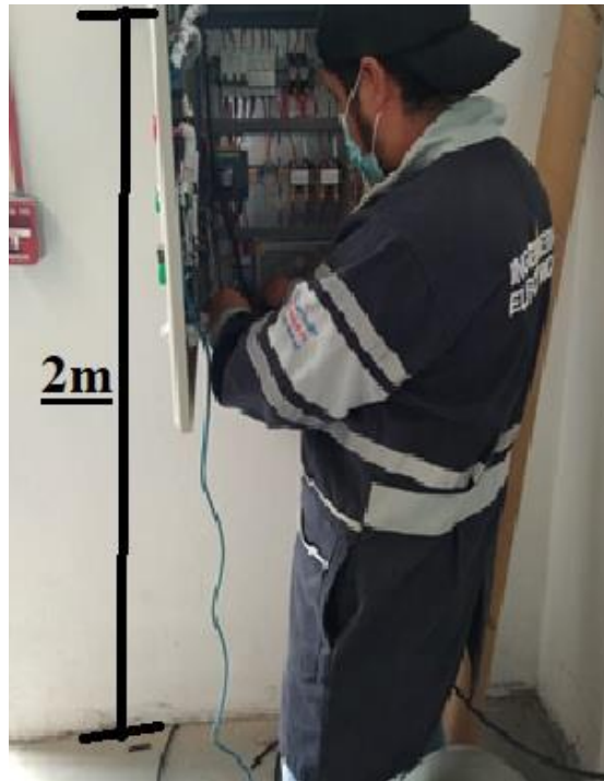
Figura 4. 10. Altura del tablero máxima (2m).
