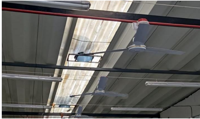
Figura 5. 7. Instalación de tres ventiladores dos extractores eólicos y un extractor mecánico.
