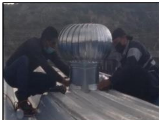
Figura 4. 5. Colocación del extractor eólico.
