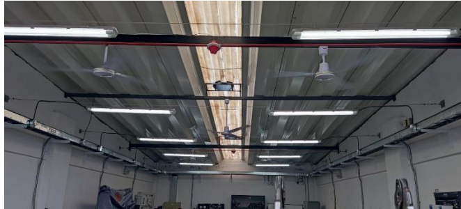
Figura 5. 9. Instalación de cinco ventiladores dos extractores eólicos y un extractor mecánico.
