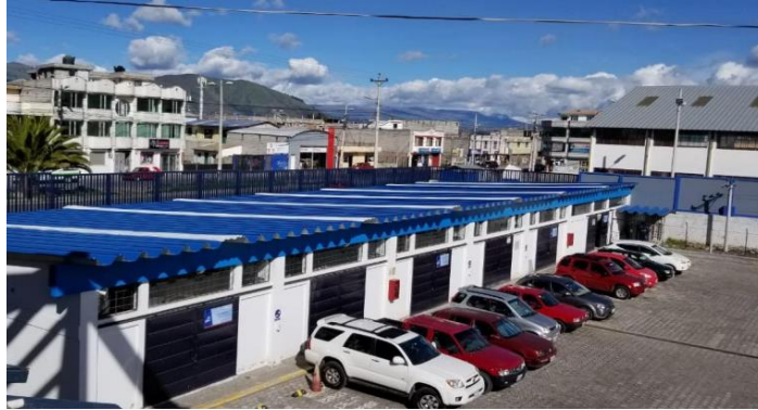
Figura 3. 1. Laboratorio de simulación, pruebas eléctricas y electromecánicas
