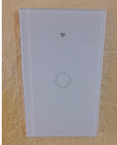
Figura 51. Verificación de conexión del interruptor
