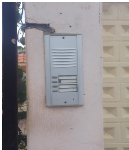
Figura 23. Intercomunicador existente
