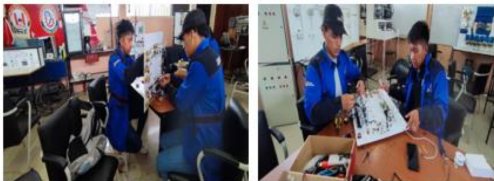
Foto 3: Conexión de los cables y dispositivos del Módulo de Aprendizaje
