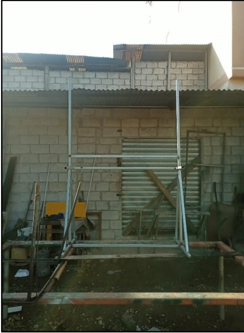
Figura 31: Construcción del módulo didáctico.
