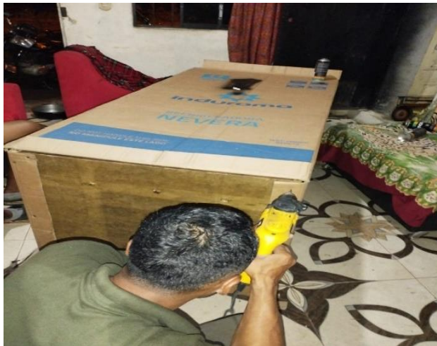
Imágenes 2. Impermeabilización del cuarto oscuro.
