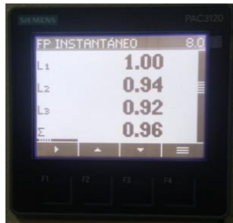
Figura 31. Verificación de medidas por el Sentron PAC3120
