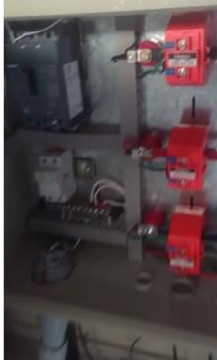
Foto 1. Instalación de sistemas eléctricos
