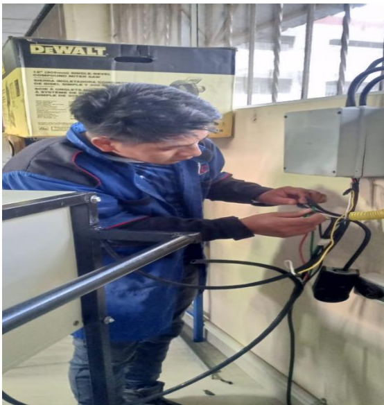
Foto 16. Instalacion del multimedidor portátil
