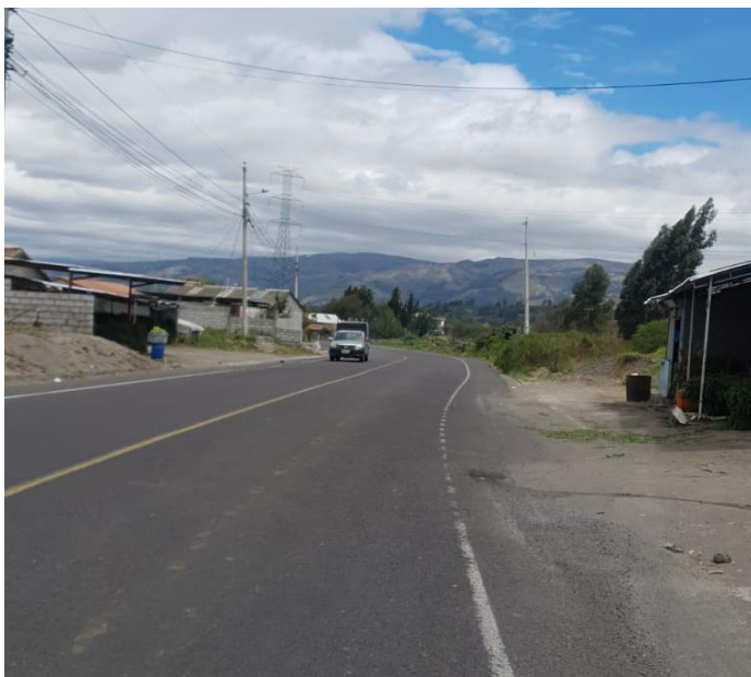
Estado de la vía de la zona centro
