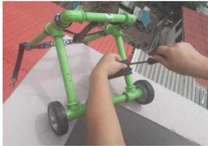
**Figura 15:** Añadir el velcro y ajustarlo con tornillos autoperforantes.
