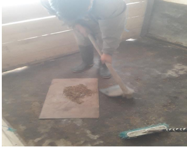
Anexo 6. Limpieza externa del galpón interno y externo
