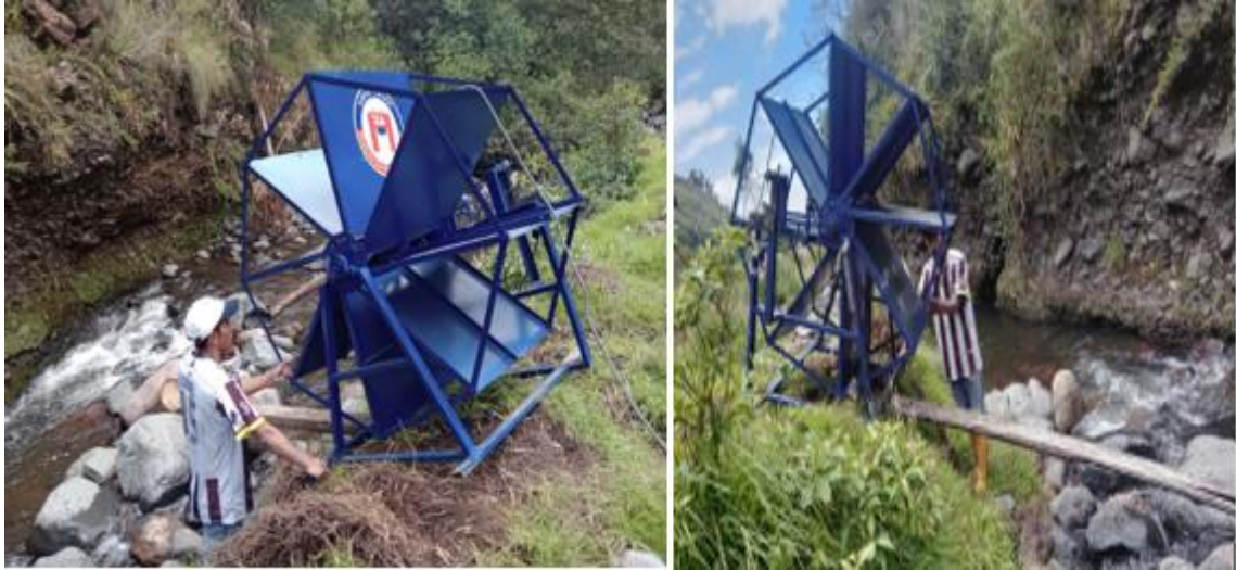
Anexo 7.20: Instalación en el caudal
