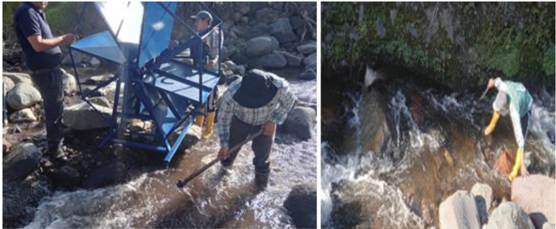
Anexo 7.21: Preparacion de sitio para instalacion de ríobomba
