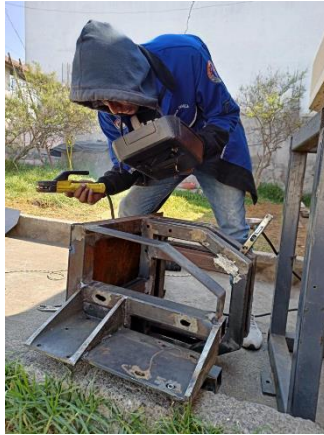
Figura 7. Soldadura de matriz triangular y base del motor
