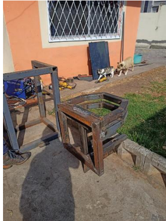
Figura 10. Unión de mesa de soporte y mesa triangular
