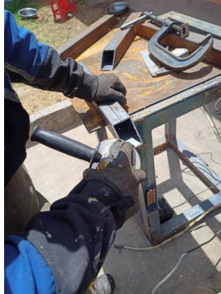
Figura 4. Armado y soldadura de matriz triangular
