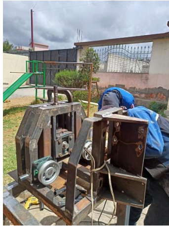
Figura 16. Colocación de poleas
