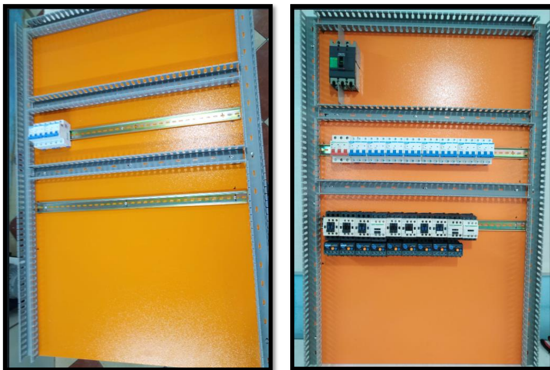
Figura X.1. Instalación de las protecciones eléctricas
