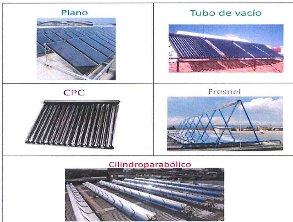
**Figura 2.6:** Distintos tipos de colectores [14].
