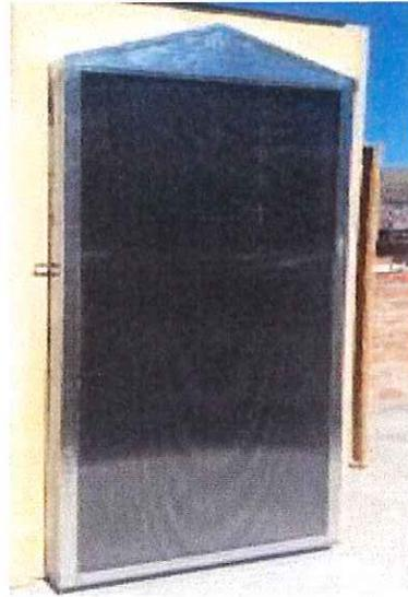
**Figura 2.17:** Colector solar de calefacción de aire instalado [23].
