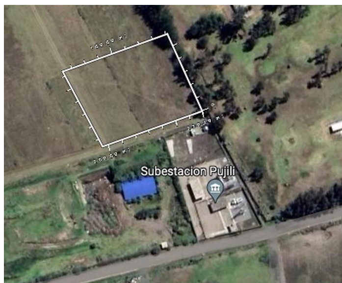
Figura 4.21: Subestación Pujilí con espacio para la instalación de GD
