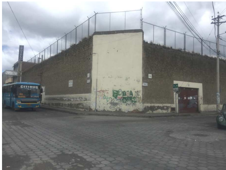
Fotografía 2.-Infraestructura de la ex Cárcel de Latacunga
