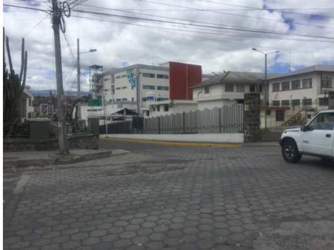
Fotografía 1.- Vista de Hospital General de Latacunga
