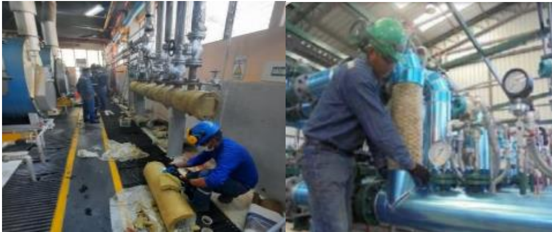
Figura 3.4: Área de montaje
