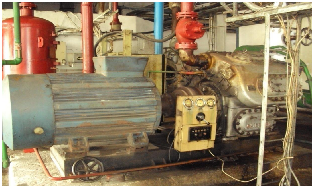
Anexo 2. Motocompresor instalado en el sistema de refrigeración de la línea de leche.
