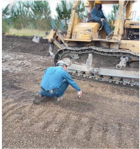
Anexo 17. Toma de datos de vibración cercano al tractor tipo oruga
