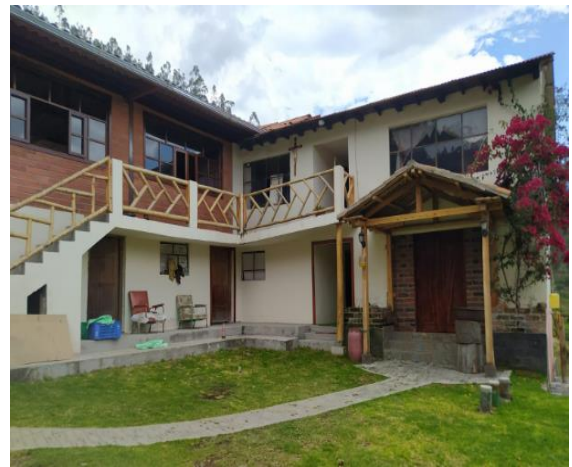
Fotografía 2. Espacio interior de la Finca
