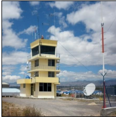
Foto 6: TORRE DE CONTROL
