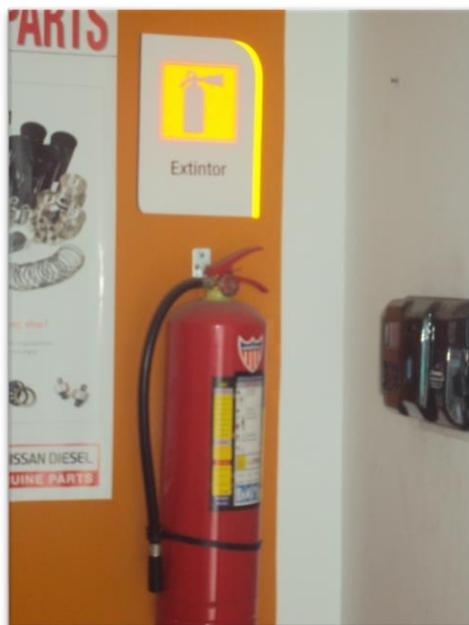
**Fotografía 2.1:** Señalización reglamentaria del extintor
