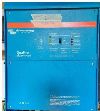
Fig. 33. Inversor Quattro 48V/5000W.
