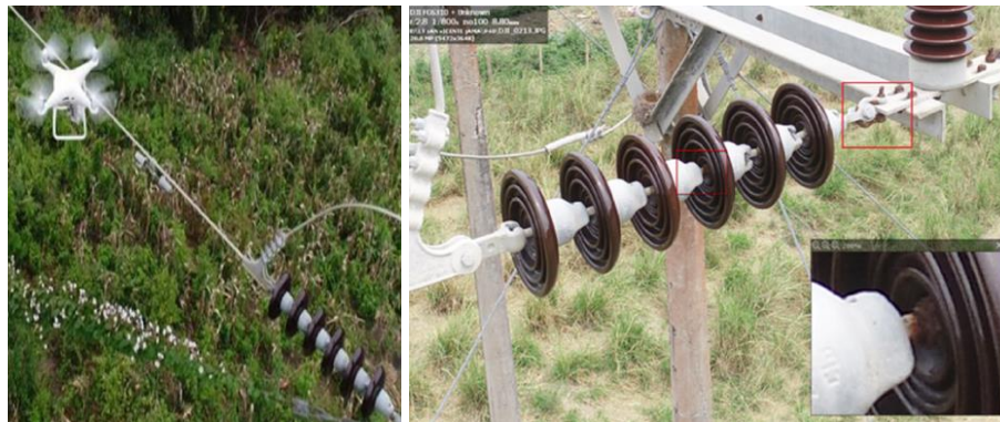
Figura 39: Inspección visual con drones
