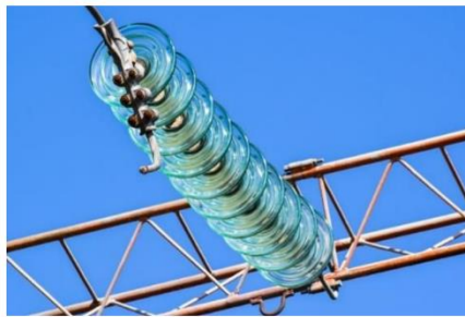
Figura 3: Cadena de aisladores de retención
