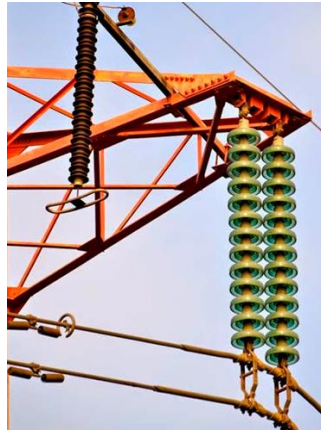
Figura 5: Cadena de aisladores de suspensión doble
