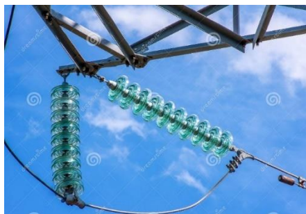
Figura 4: Cadena de aisladores de suspensión
