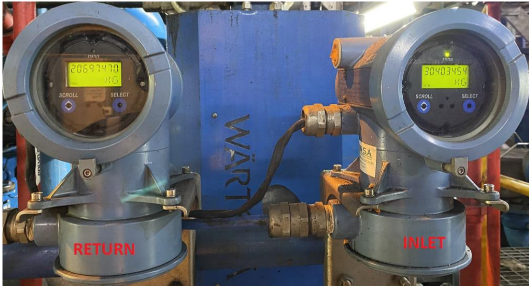
Figura 2-4. Medición de flujo de combustible en prueba, GE-3170A.
