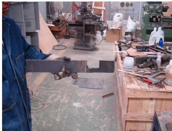
Figura 46: Plancha de hierro cortada para la estructura
