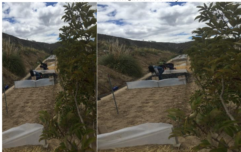
Anexo 20: Realización de hoyo
