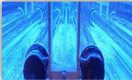
Ilustración 16. Desinfección del agua lámpara (UV)
