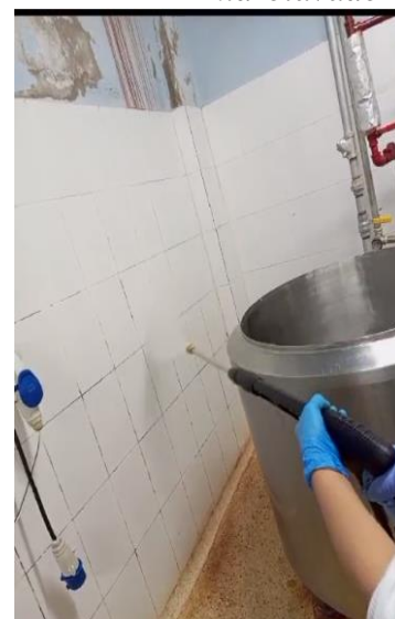
Ilustración 12. aplicación de detergente en paredes con la hidrolavadora.
