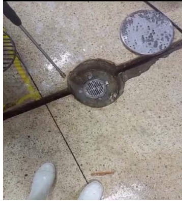
Ilustración 5. limpieza de drenaje sacando impurezas como pepas, tierra.
