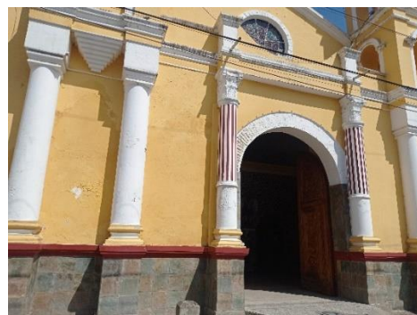
Figura 79 Fachada principal de la Iglesia San Miguel de Sigchos
