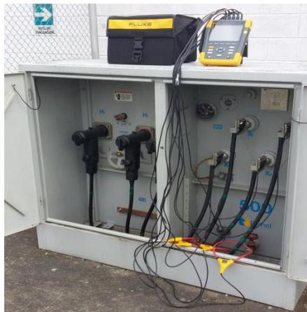
**Figura 3. 3.- Conexión del analizador trifásico Fluke 435 II al transformador E-10003-TR**
