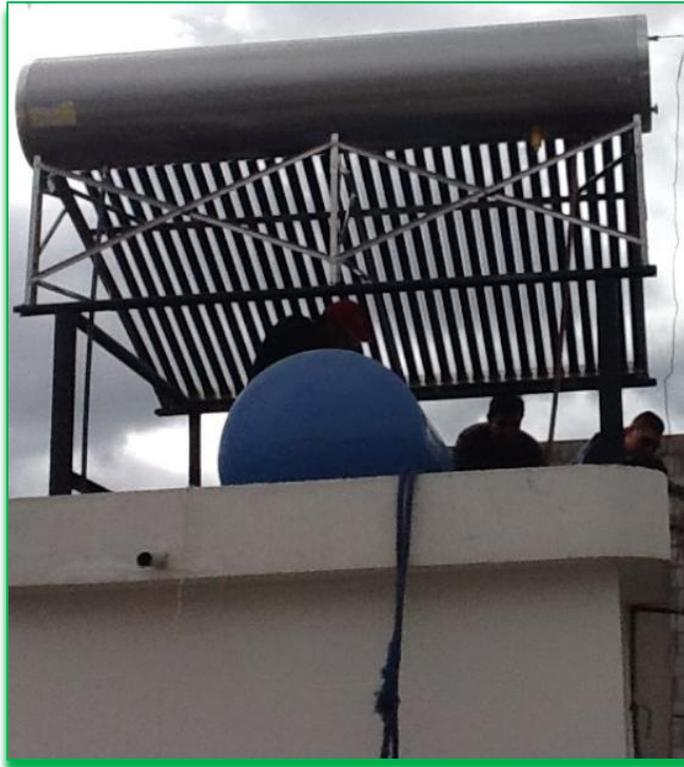
***Figura 17:*** Calentador solar de tubos al vacío
